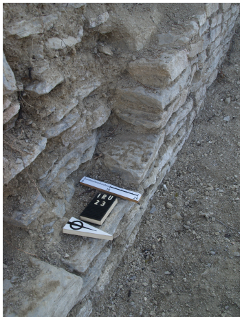
Fot. 2. Hiladas del paramento interior puestas al descubierto
